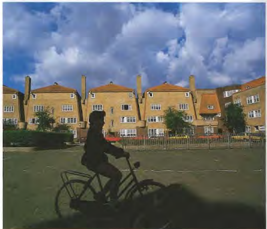
Amsterdam, Henriëtte Ronnerplein 1923 Architect: M. de Klerk Amsterdamse Woningbouwvereniging De Dageraad
